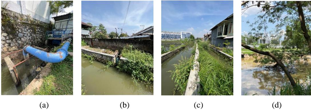
**Gambar 1.** Kondisi Bangunan Pengendali Banjir di Kelurahan Rancabolang, (a) pompa air, (b) pintu air, (c) tanggul sungai, (d) kolam retensi
