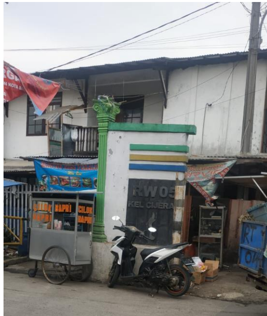
Gambar 6. Permukiman Kumuh di Kecamatan Bandung Kulon
