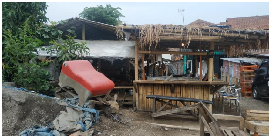
Gambar 7. Permukiman Kumuh di Kecamatan Bandung Kulon
