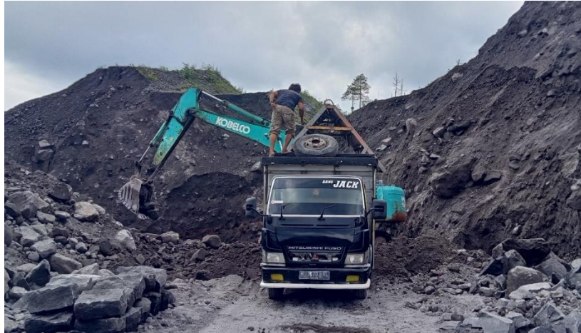
Gambar 2. Proses Pengambilan Material Menggunakan Mesin (Eskavator)
